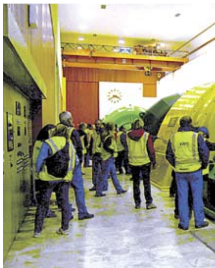
Besuch in der riesigen Maschinenhalle des Kraftwerks Grimsel 2.
